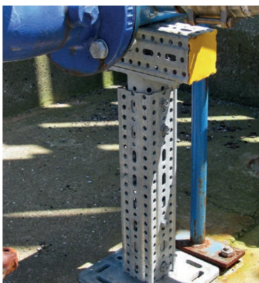
nosná T konzole a siFramo 80 několik měsíců po montáži
