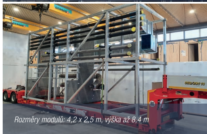
Moduly byly do budovy vloženy jeřábem přes stavební otvory.
