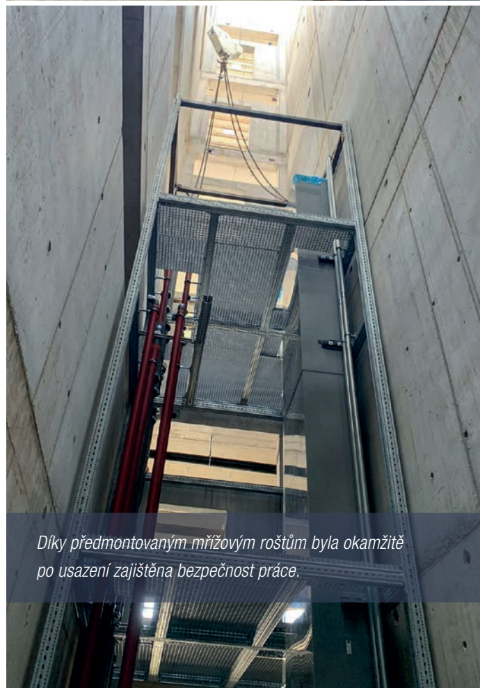
Rozměry modulů: 4,2 x 2,5 m, výška až 8,4 m
